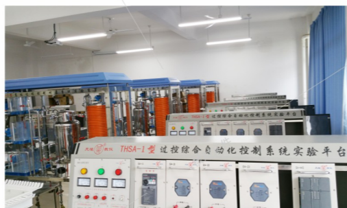
过控综合自动化控制系统实验平台
